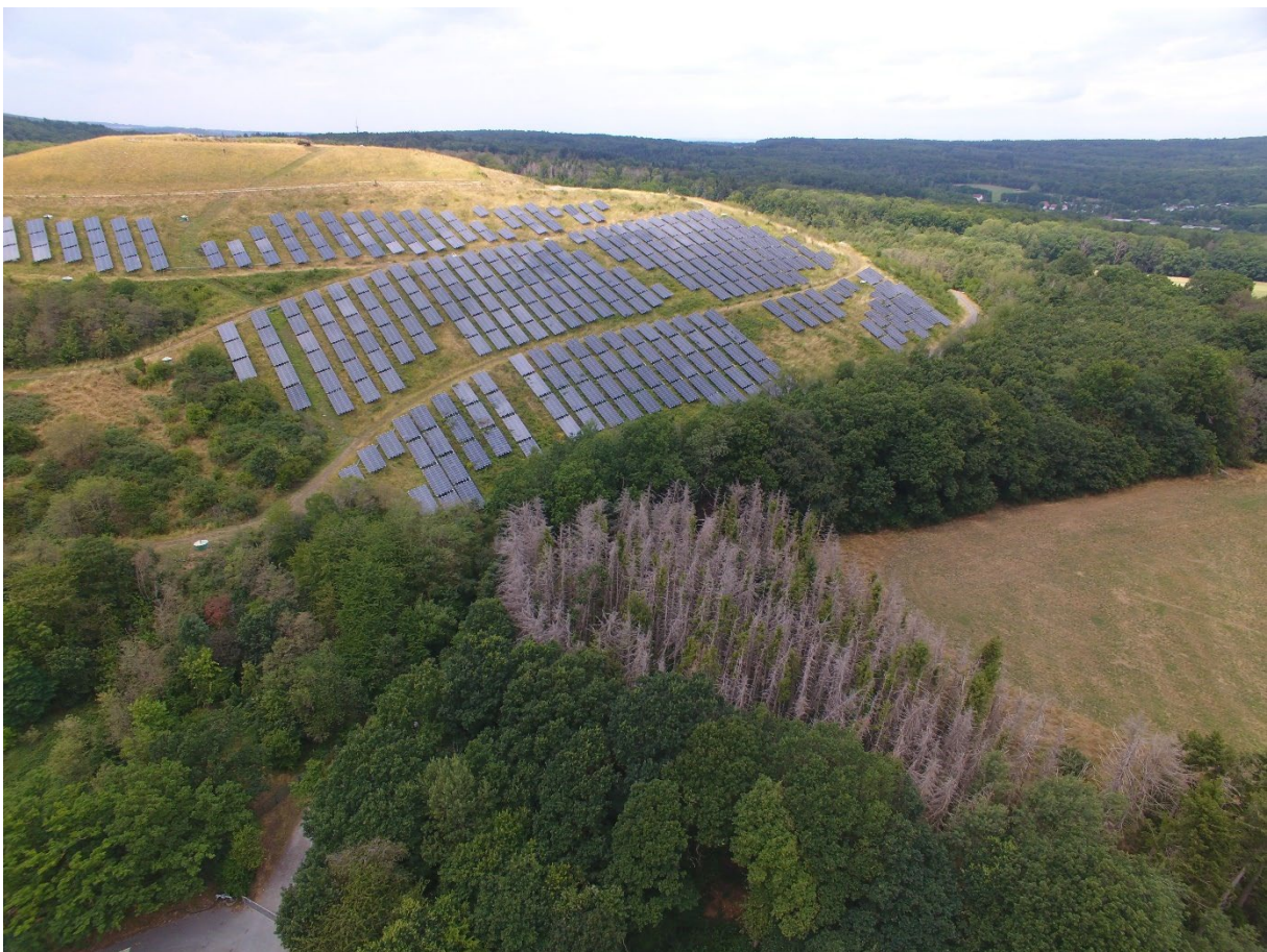
Abb. 5: Deponiekörper mit PV-Freiflächenanlagen (Stand: Juli 2023)
