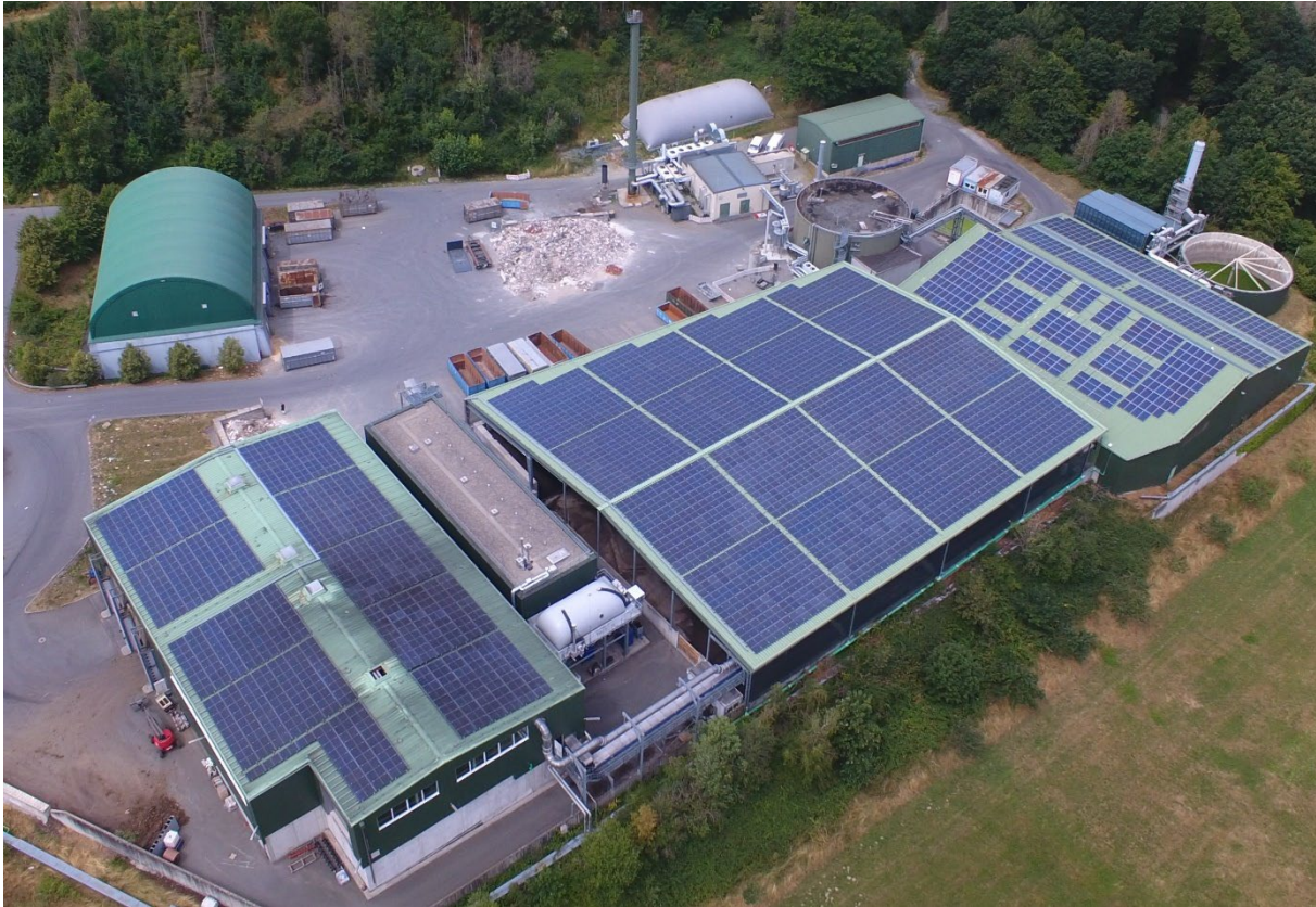
Abb. 6: Biogasanlage Deponiepark Brandholz (Stand: Juli 2023)
